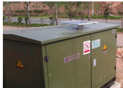
图 4 环网柜测温现场安装图
