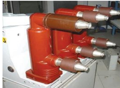
图 4 套筒式安装测温传感器
