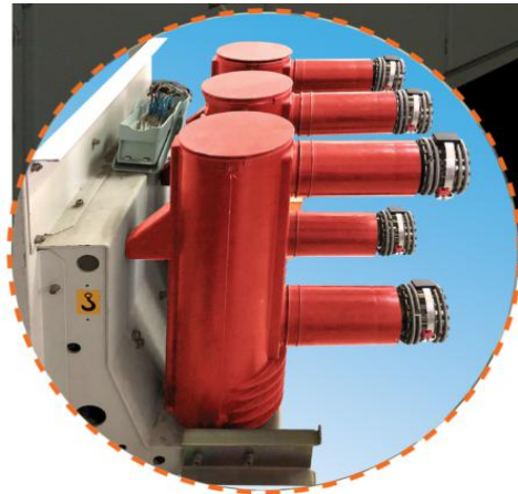
图 2 测温传感器现场安装图
