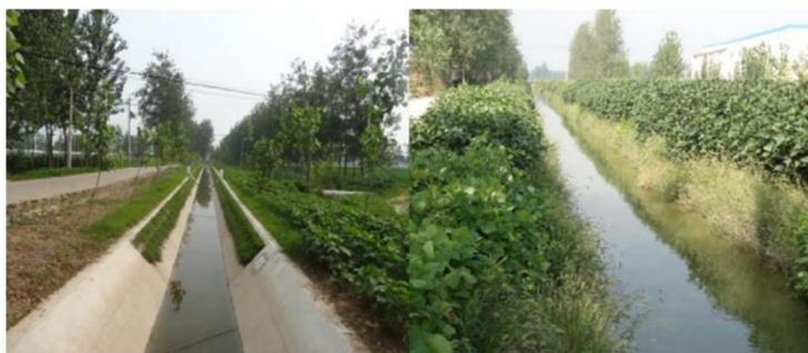
已建混凝土生态防渗渠道改造图
