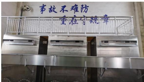
纺织园水厂同步除硬度、铁、锰、氨氮装置正面图
