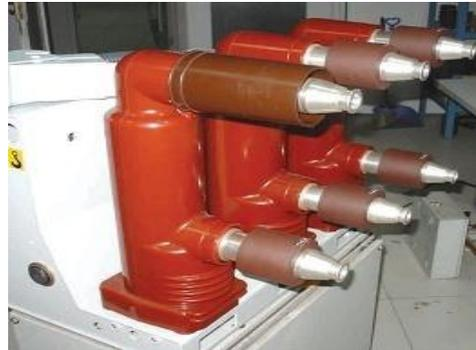
图 4 套筒式安装测温传感器
