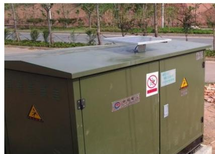
图4 环网柜测温现场安装图
