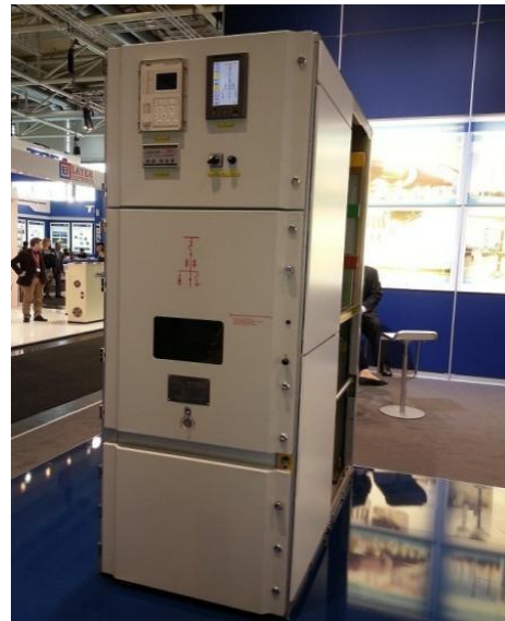
图 2 基于一二次深度融合的自感知开关柜
