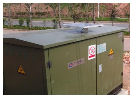
图 4 环网柜测温现场安装图
