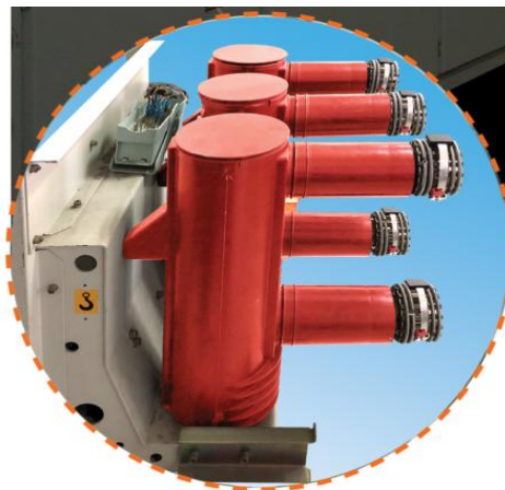
图 2 测温传感器现场安装图
