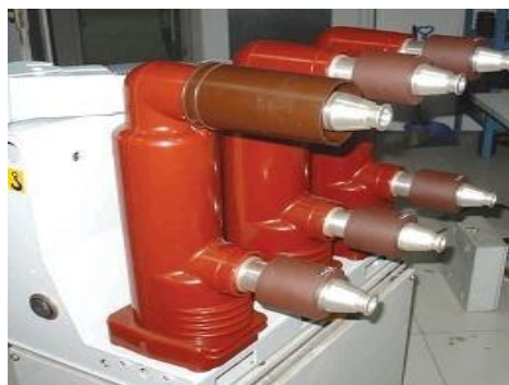
图 4 套筒式安装测温传感器
