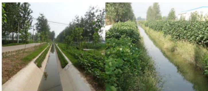
已建混凝土生态防渗渠道改造图
